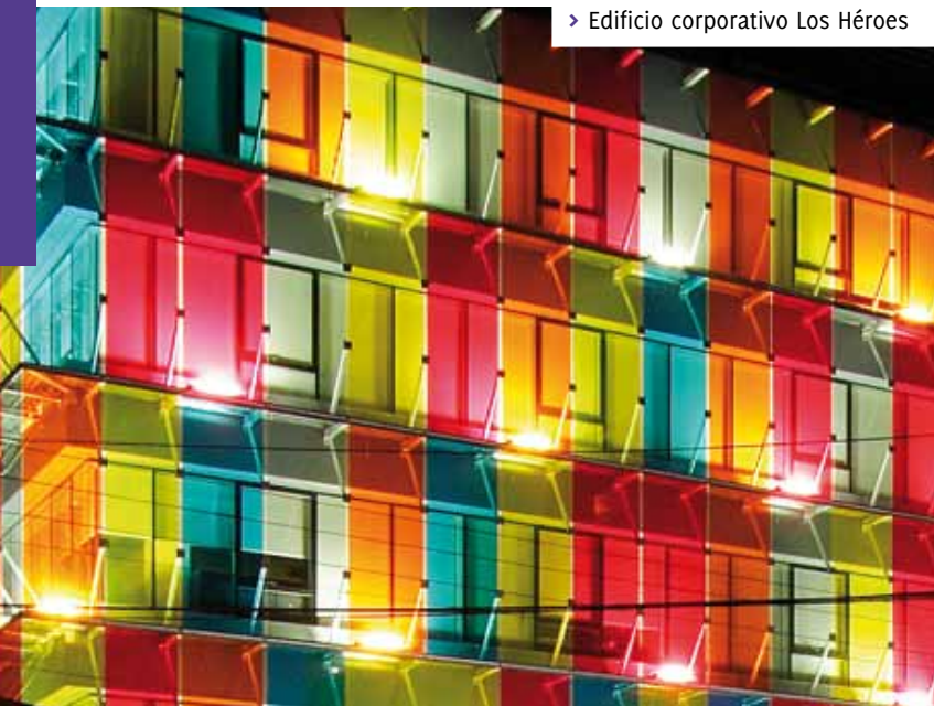
► Edificio corporativo Los Héroes
